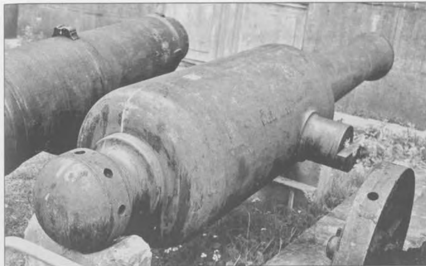
Первая тяжелая (60-фунтовая) пушка Круппа, доставленная в Россию. Пушка стальная, но на всякий случай Крупп скрепил ее среднюю и казенную части большим чугунным кожухом
